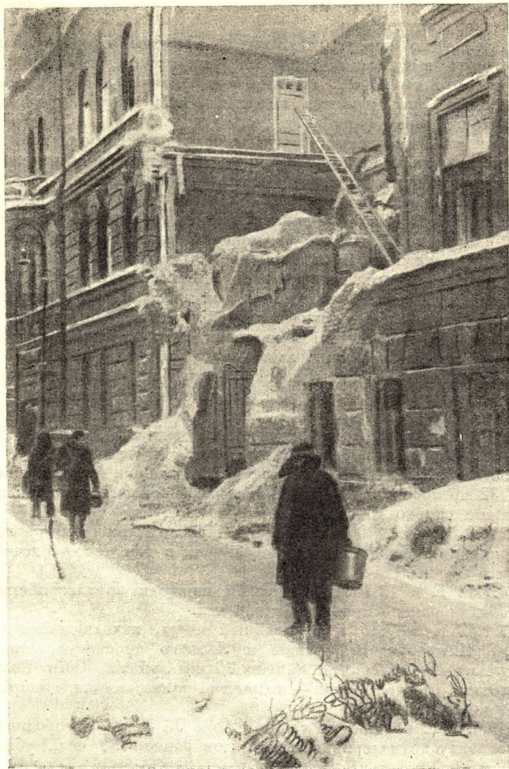
Жилой дом, разрушенный попаданием снаряда при артобстреле
