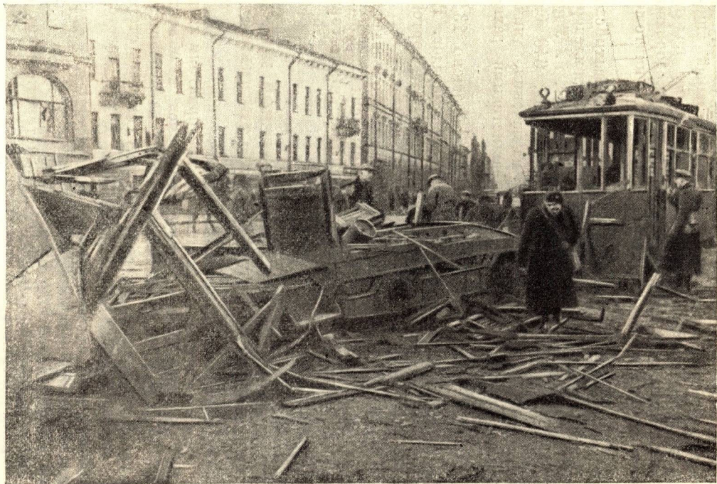
Разрушенный попаданием фугасной бомбы трамвай на Владимирской площади
